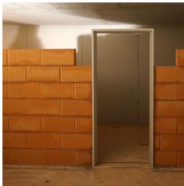
Dělicí konstrukce z cihel
